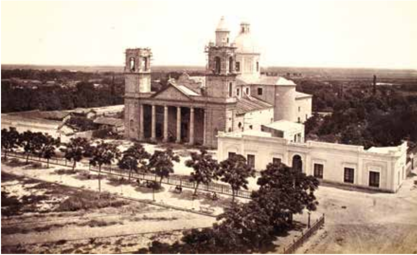
Iglesia Catedral en construcción
