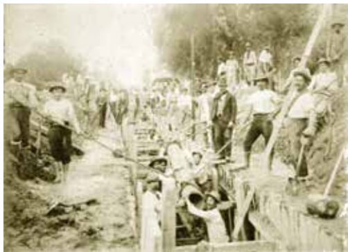
Instalación de cloacas (1912)
