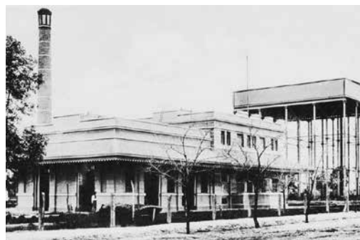
Tanque de agua (1912)
