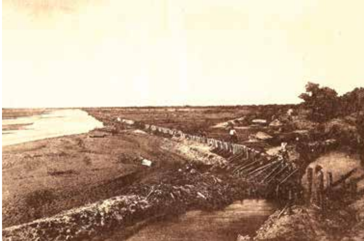
Obras de defensa del río
