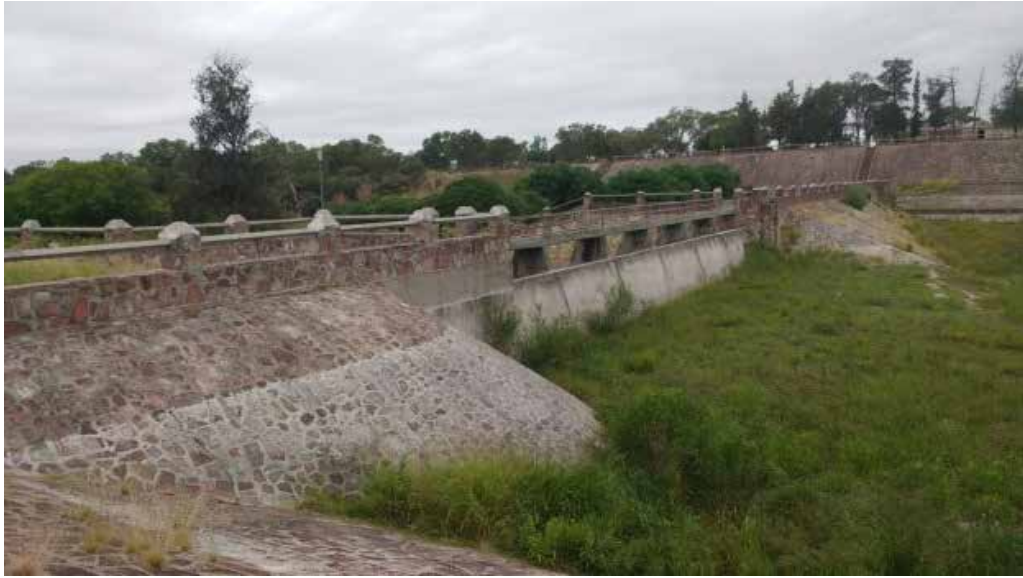
Dique de Báez, seco, sin agua (foto A.V.C., 9/03/2016)
